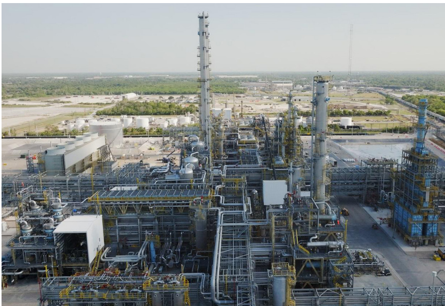
ExxonMobil hợp tác với Air Liquide trong dự án hydrogen carbon thấp lớn nhất thế giới tại Baytown, Texas, Mỹ. Nguồn: ExxonMobil
